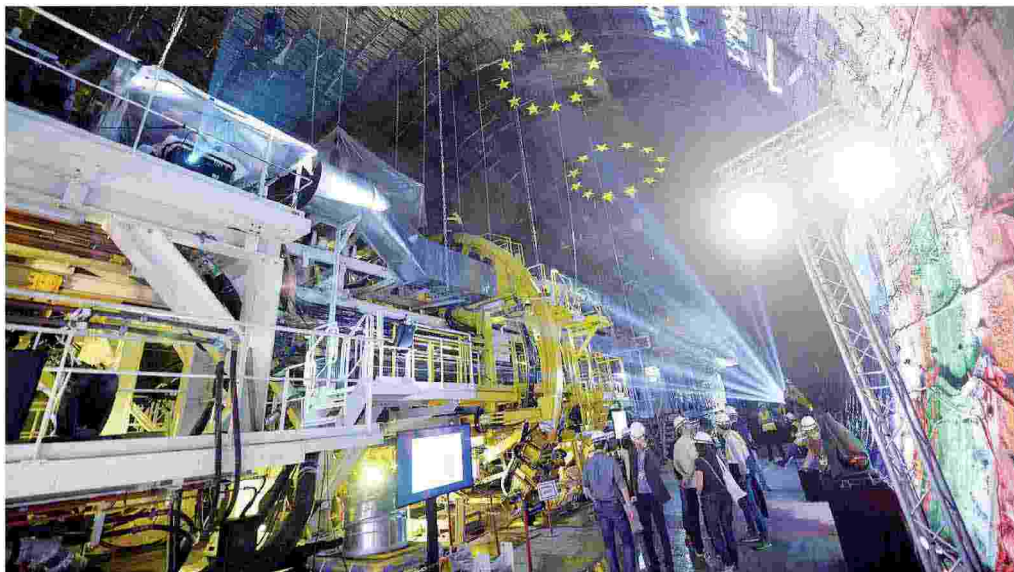
La presentazione dello scavo del versante francese del tunnel ferroviario dell'Alta velocità, il 21 luglio 2016
